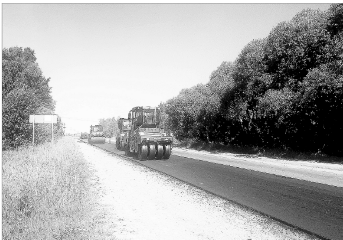
Ремонт автодороги Торжок – Высокое – Берново – Старица
